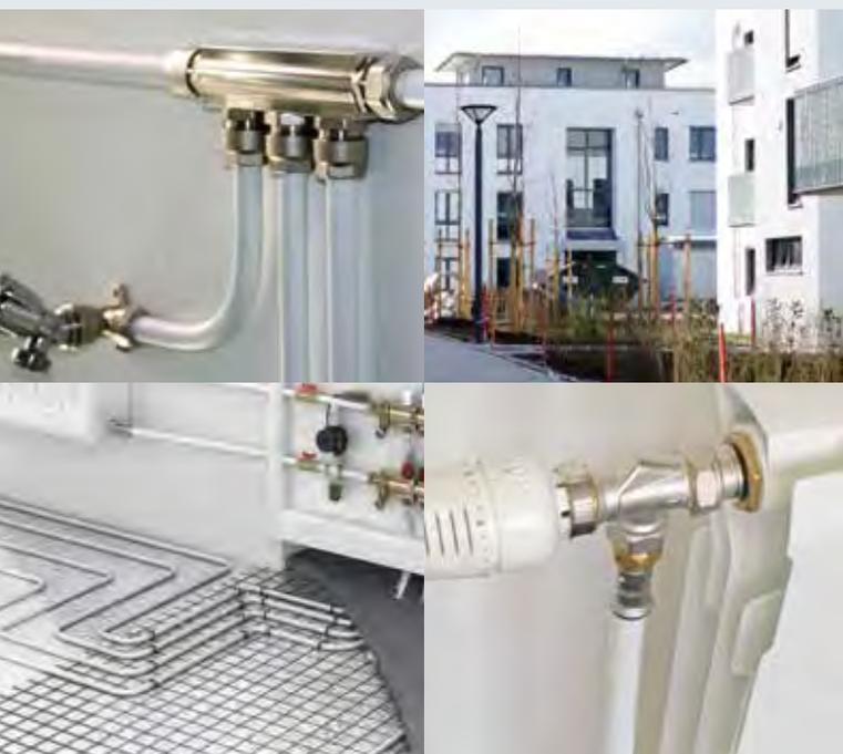
PCBT : Plancher Chauffant Basse Température
